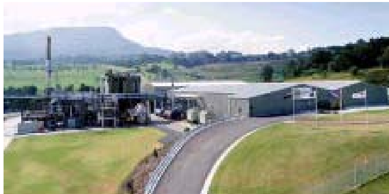
Figure 20 SWERF plant, Wollongong
